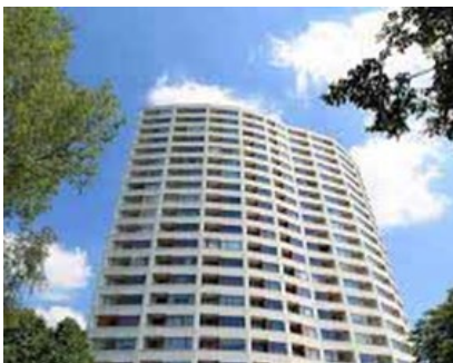
B: Neue Vahr Aalto-Hochhaus apartment
