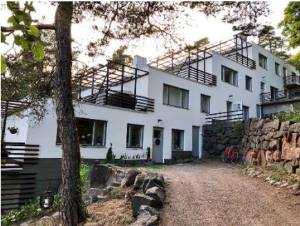
A: Kauttua terraced house
